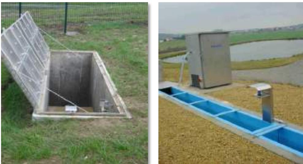
**Figure 9 : Implantations possibles d'un canal venturi (En surface ou en regard enterré)**
