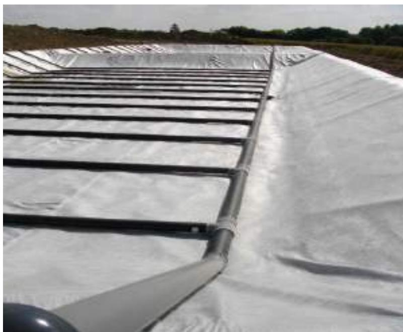
*Figure 12 : Réseau de drainage des filtres plantés*
